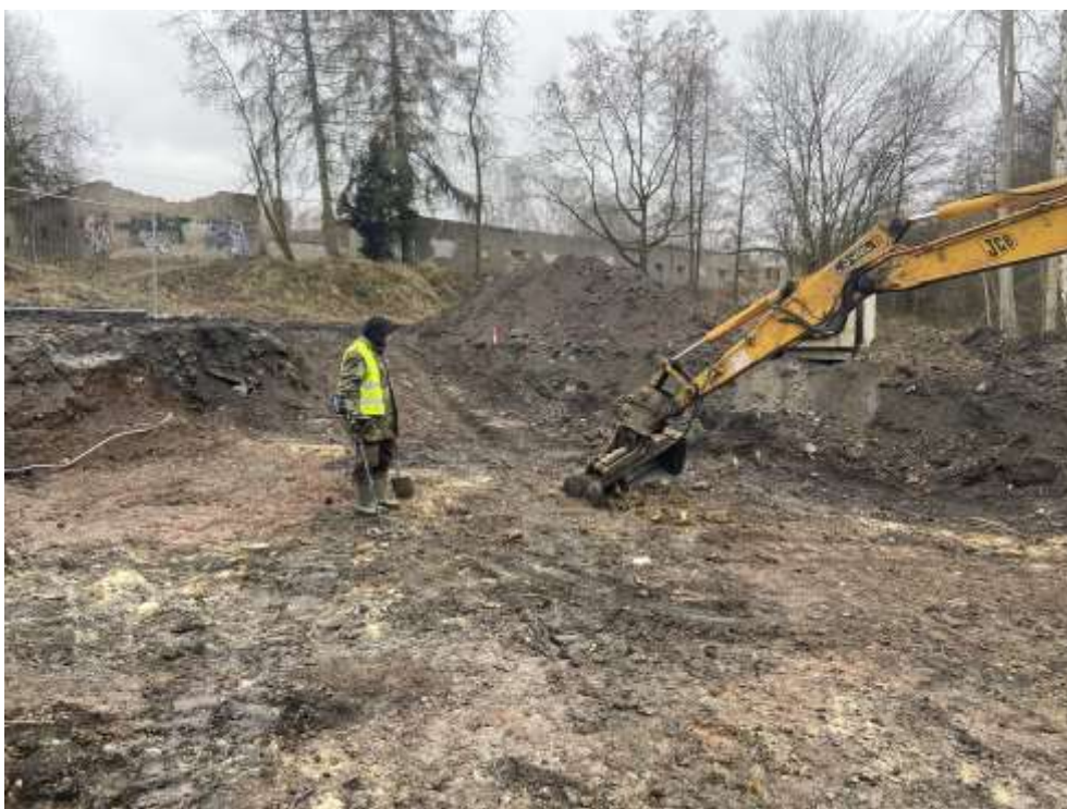
Obr.17 ...tak i sondami kopanými bagrem pod dozorem pyrotechnika.
