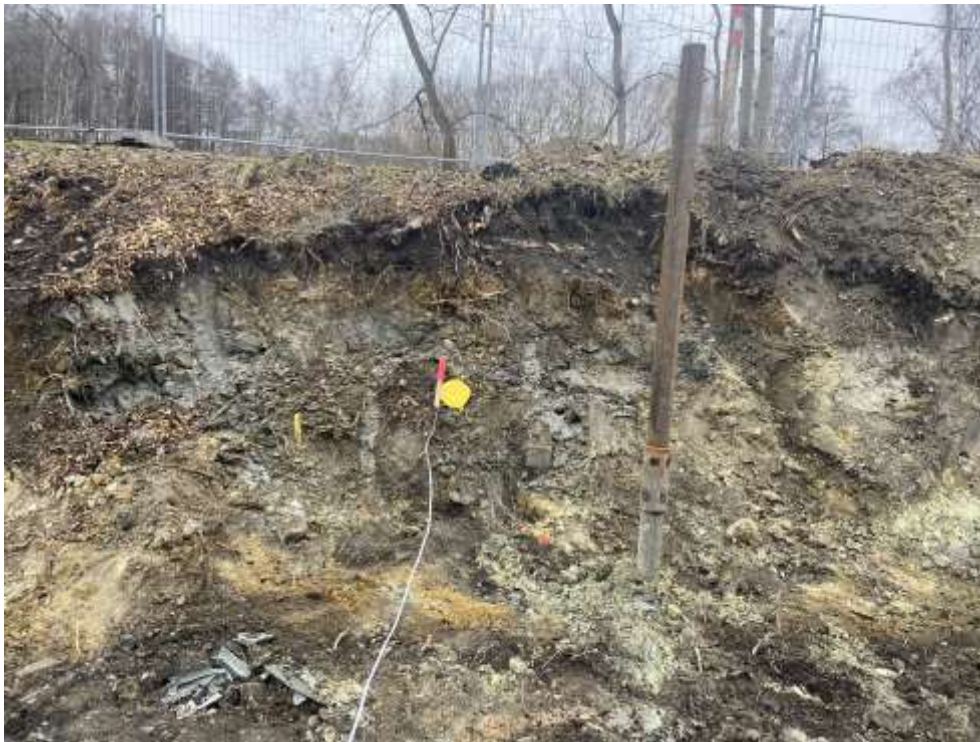
Obr.10 Pozice zkušební mikropiloty vůči zkoumané ploše
