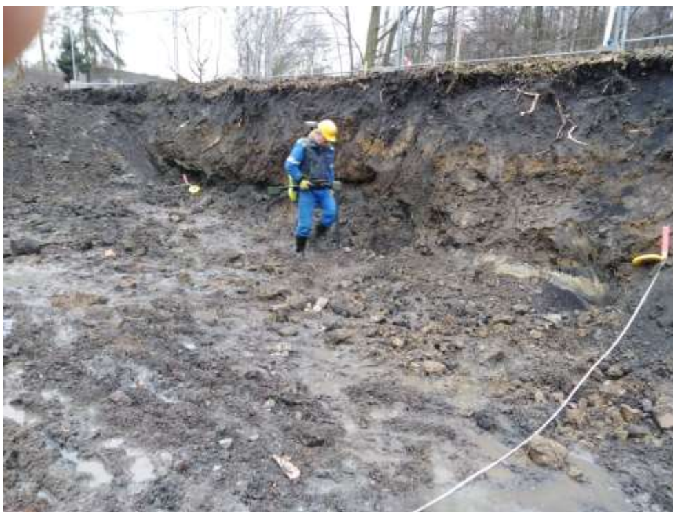
Obr.12 Pyrotechnik při průzkumu plochy 10. Hráz rybníka byla zdrojem signálů (duchů), které pocházely z materiálu hráze a jejího podloží.
