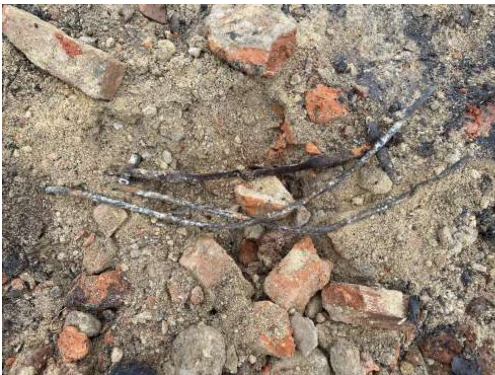
Obr.20 Stavební suť s ocelovou výztuží
