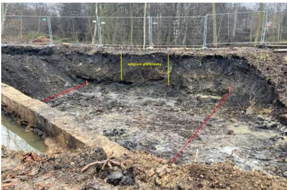
Obr.11 Pohled na připravenou plochu 10. Ze zakresu vytýčení je zřejmý přesah zkoumané plochy oproti ploše budoucího pilíře.
