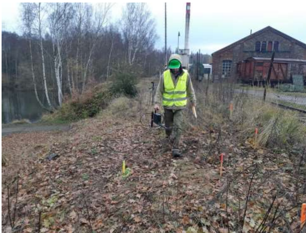
Obr.5 Vzhledem k nemožnosti použít magnetometr byla plocha prozkoumána pomocí detektoru TM808. Provedeným zkoumáním bylo potvrzeno, že zkoumaná plocha je překryta vrstvami různých navážek s vysokým obsahem železných a železobetonových předmětů.
