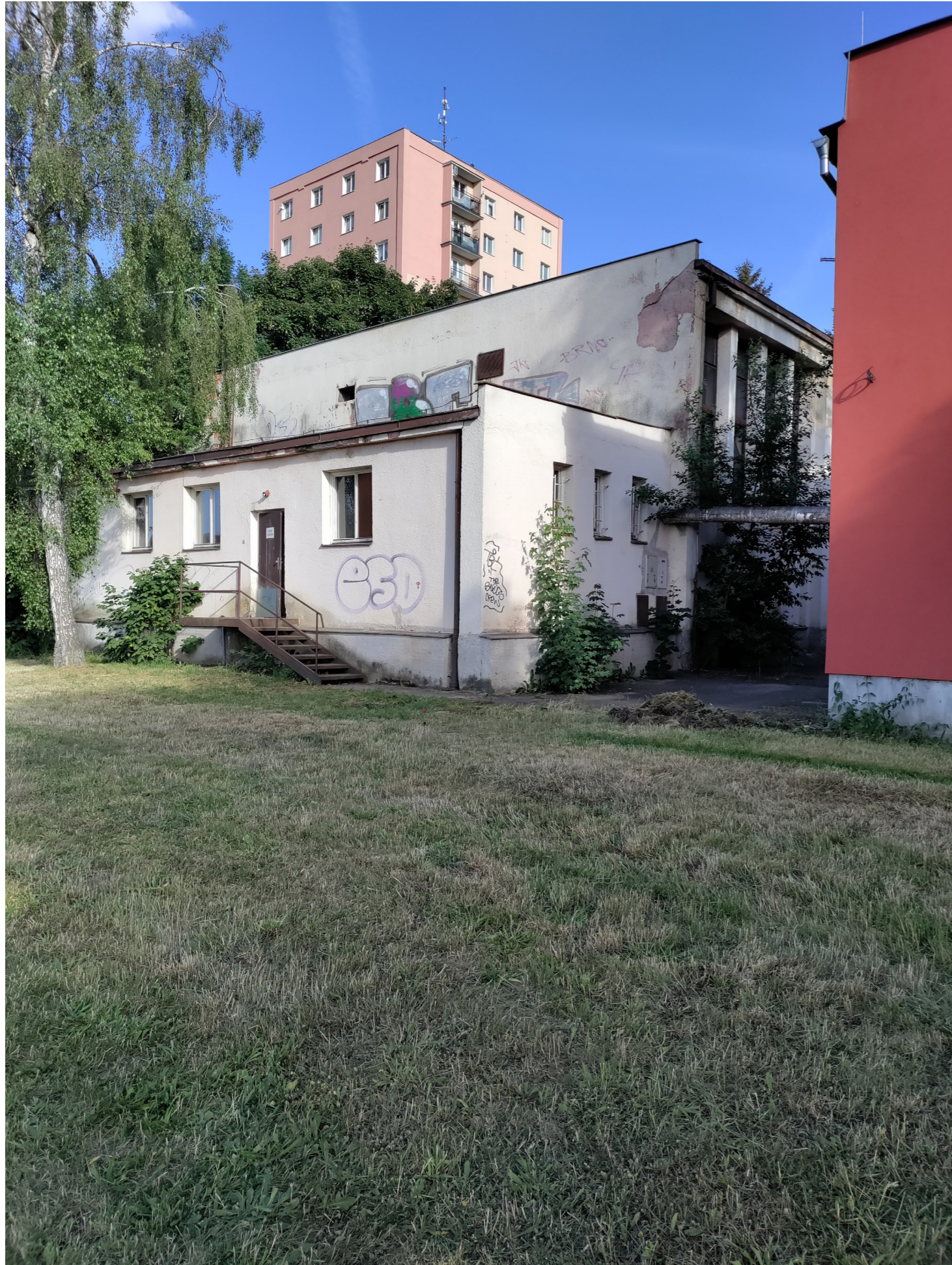
fotografie stávajícího stavu
